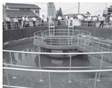
▲御坂サイフォン橋の上で説明を聞く。淡河川疏水の主要施設。農業用水路としては国内初の鋼管を使用したサイフォンで、イギリス人パーマー氏が設計監督し、明治24年完成
