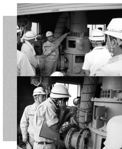
立軸ポンプの温度・振動・回転音の診断
