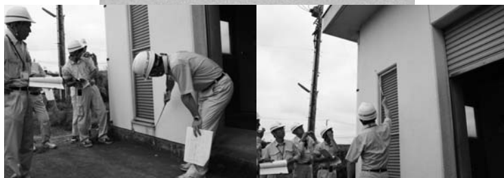
上屋の基礎・外壁等の点検
