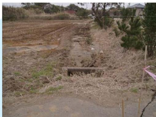
旭市矢指地域は、地震の揺れで液状化現象による、隆起や陥没が至る所で発生し、柵渠護岸排水路も隆起や陥没が著しく、また一部は砂が盛り上がり排水路を埋め、水田と同じ高さとなったが、応急工事として水路内の土砂を取り除き、排水が可能となるまで復旧しました。
