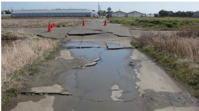
旭市矢指地域は、地震の揺れで液状化現象による、隆起や陥没に至る所で発生し、道路下埋設のパイプライン(塩ビ管)が破断、水稲の植付け時期が間近の為、4月下旬から5月中旬にかけて応急本工事にて復旧を行い、5月下旬に田植えを行う事が出来ました。
