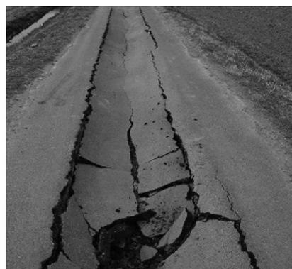
写真2 路面の陥没
