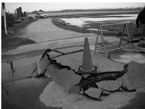
写真1 中継ポンプ施設の浮き上がり
