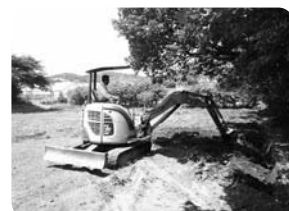
重機作業を千葉県建設業協会館山支部に依頼
