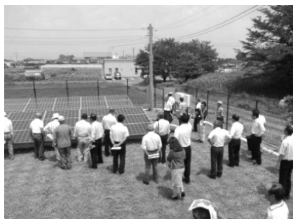
太陽光発電施設
