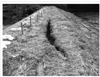
▲地震で亀裂が生じたため池
