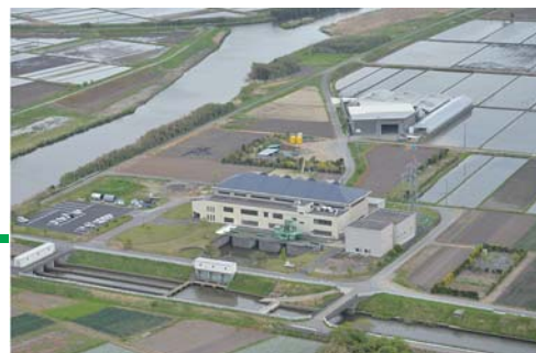
▲両総用水第2揚水機場
