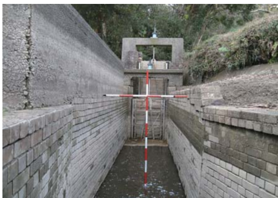
▲取水口(ため池側)
