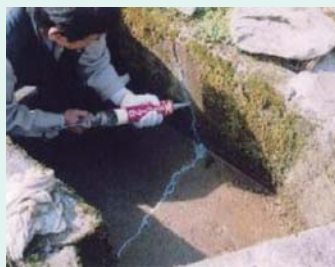
①施設の軽微な補修(水路)
