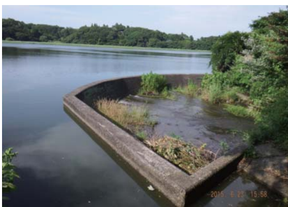
▲円弧式越流堰洪水吐
