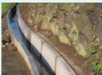
コンクリート水路の更新
