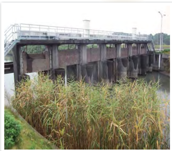
◀清水堰 (上流側より)
