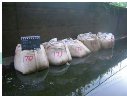
詰込作業後の土のう袋
