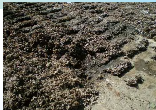
カワヒバリガイの発生状況(水路底部拡大)
