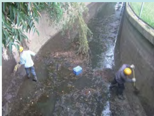
人力による除去作業
