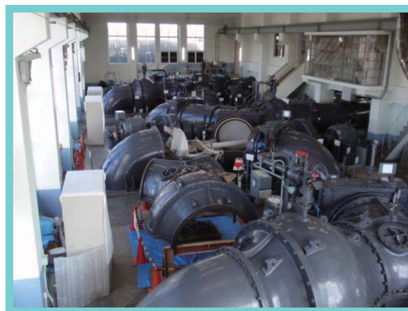
手賀排水機場(修繕中)
