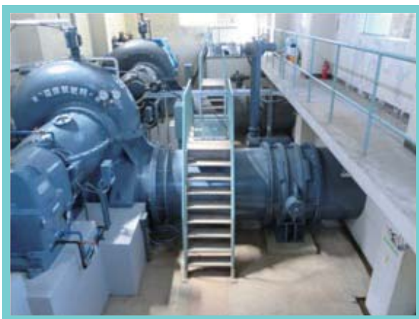
青山排水機場(修繕後)
