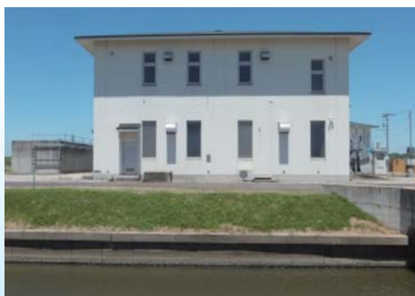
大竹排水機場
