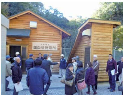
小水力発電施設全景
