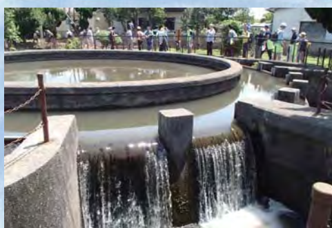
▲東金市内の円筒分水工
