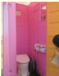
▲宗吾西機場現場の女性用仮設トイレ
