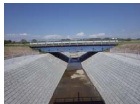
張りブロック区間 復旧後
