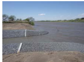
河川合流部(右岸) 復旧後
