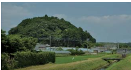
丸山と船越揚水機場
