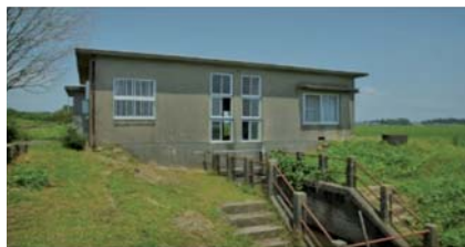
船越揚水機場(廃止予定)
