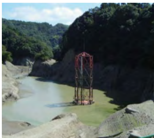
▲更新前の取水設備
