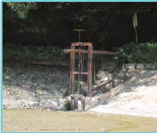
▶ 取水工(ため池側)
