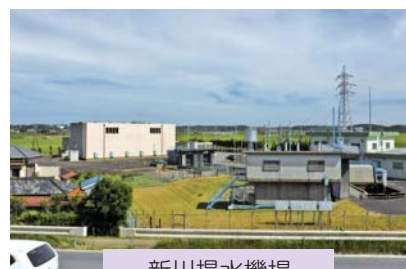
新川揚水機場
