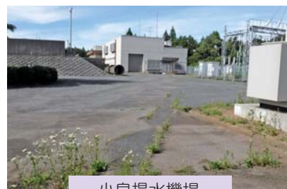
小泉揚水機場
