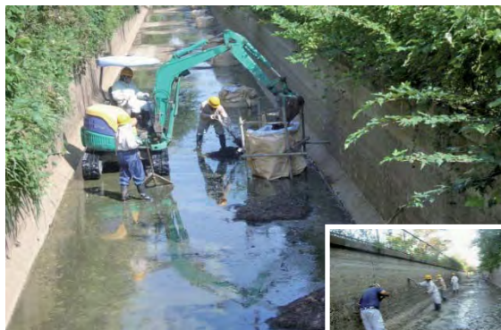
▲掻き落としと大型土のうへの詰込
