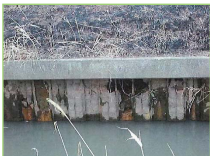
3号排水路(鋼矢板区間)
