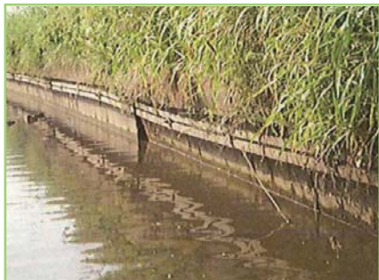
2号排水路(コンクリート矢板区間)
