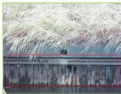
1号排水路(鋼矢板区間)
