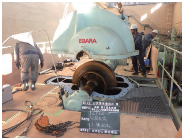
▲上部ケーシング 取り外し
