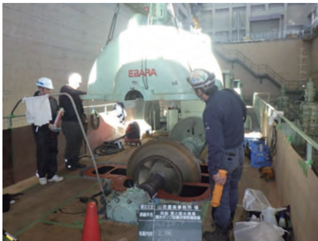
▲上部ケーシング 取り付け
