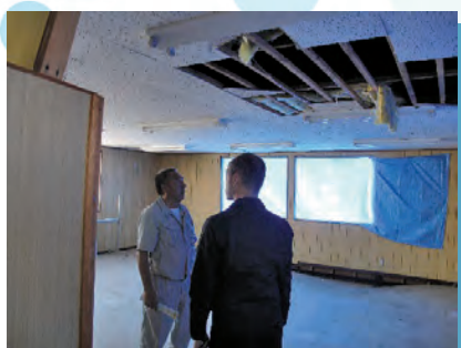
▲ 鋸南土地改良区2F事務室
