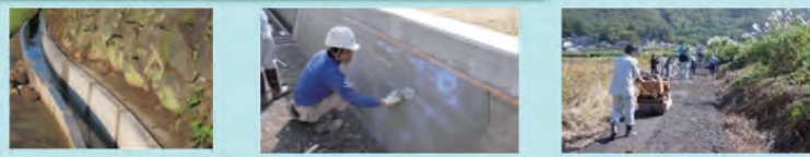
素掘り水路からコンクリート水路への更新 老朽化した水路壁のコーティング 未舗装の農道をアスファルトで舗装
