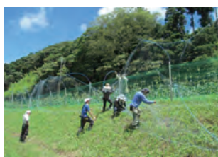
写真7 サル用防護柵の設置作業
