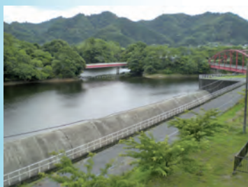
▲戸面原ダム 余水吐水路
