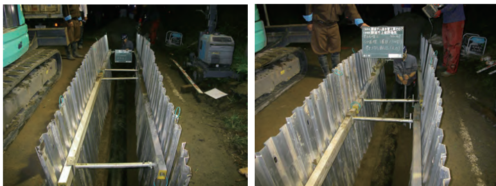
▲アルミ製矢板による土留めの利用
