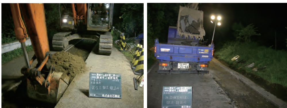
▲全面通行止めによる夜間施工
