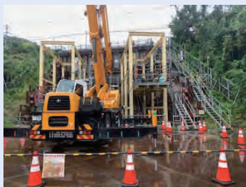
JR横断工の施工状況
