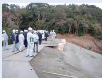
護岸工事現場における説明(大正地区)
