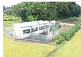
小森揚水機場
