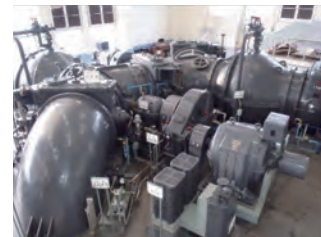
(現)手賀排水機場
