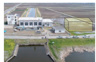
手賀第二排水機場
