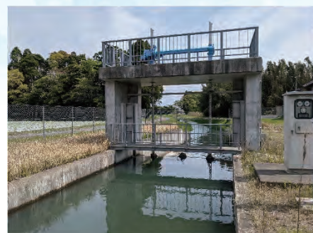
図6 地下水止めの例(新川地区)
