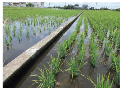
図5 コンクリート畦畔(高さ12cm程度)
