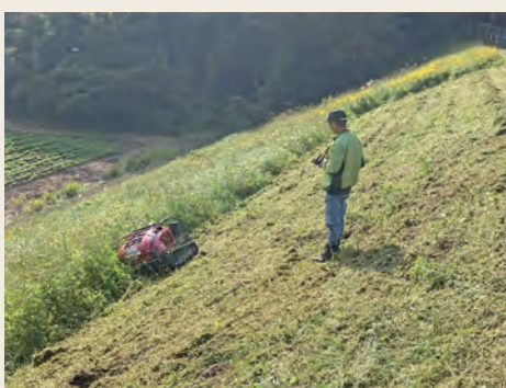
リモコン草刈機による堤体の草刈
