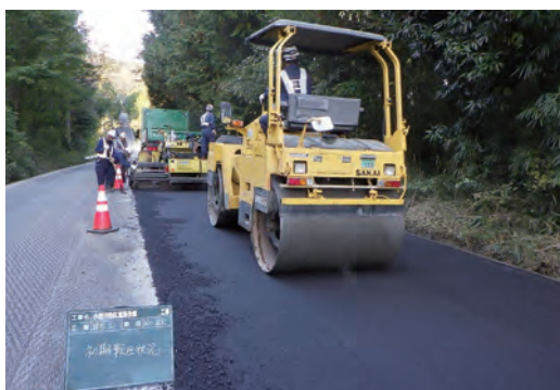
◀アスファルト打設状況
