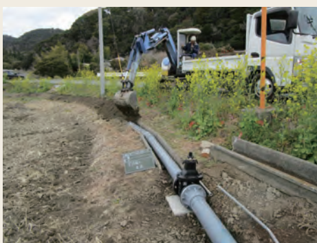
施工状況(令和2年度)
