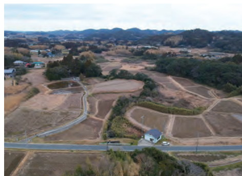
▲[基盤整備前の状況:大楠地区]
