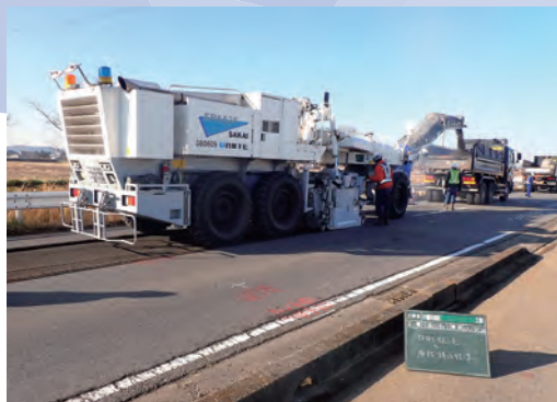
▲既設舗装撤去状況
