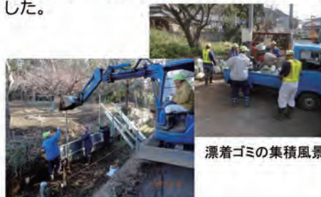
水路の補修風景
