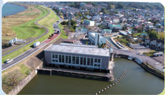
昭和31年に農水省が建設した手賀排水機場
