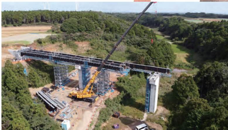
6号橋版桁施工中
