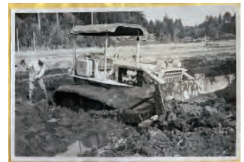
昭和40年頃のほ場整備工事
