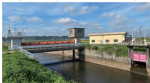
ストマネ事業実施中の富口堰
