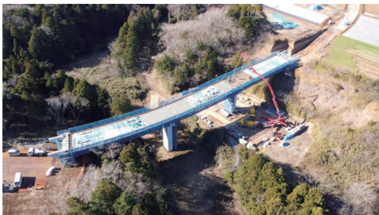
床版コンクリート打設中
