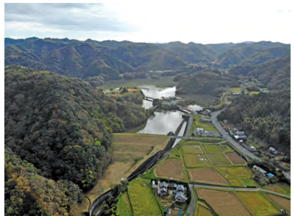
戸面原ダム全景
